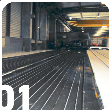
TENSION DES TORONS DE PRÉCONTRAITE
